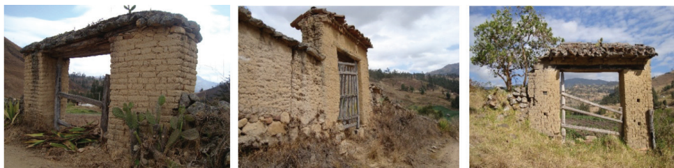
Imagen 4. Portales en adobe, tapia pisada al ingreso de algunas fincas. Fuente: Moreno (2015)
