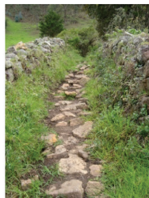
Imagen 2. Muro de contención en piedra al lado y lado del camino y la calzada. Fuente: Moreno (2015).
