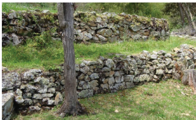
Imagen 2. Muro de contención en piedra al lado y lado del camino y la calzada. Fuente: Moreno (2015).
