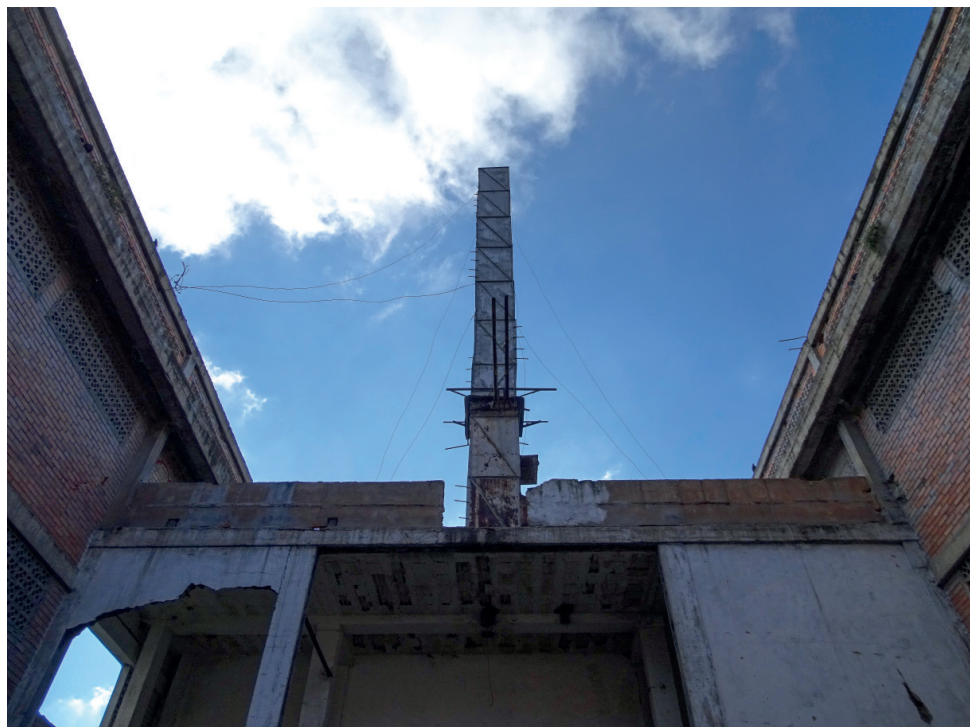
Imagen 8. Ruinas de Ferroaleaciones de Colombia, vista de una de las chimeneas. Fuente: Autor (2016)
