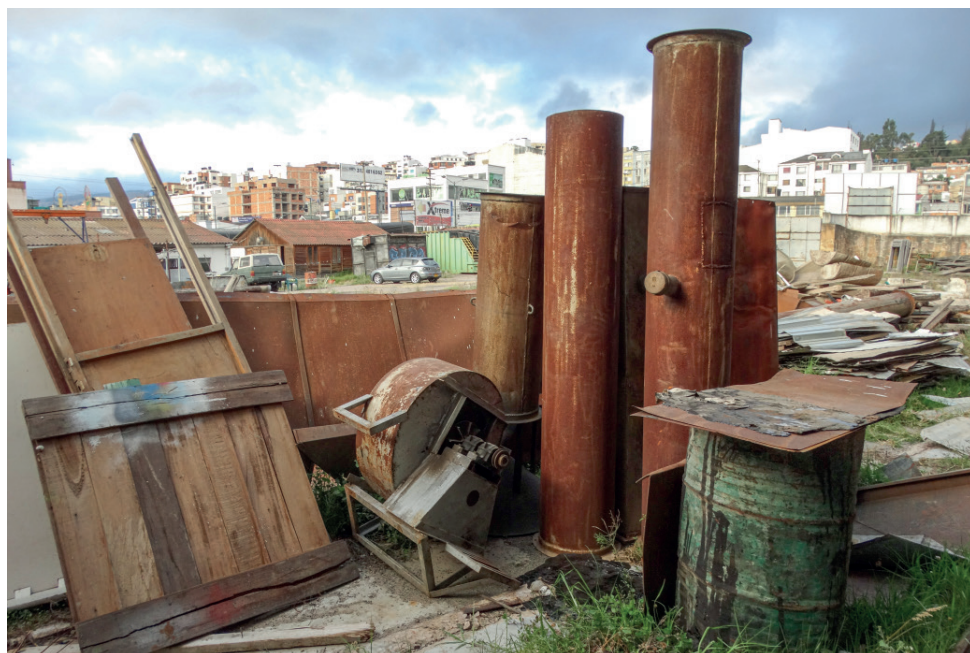
Imagen 7. Ruinas Ferroaleaciones de Colombia. Vista hacia el barrio José Joaquín Camacho. Fuente: Autor (2017).
