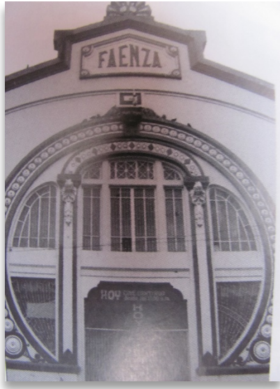
Fotografía 5: Exterior Teatro Faenza (1924). En Salas de cine (Ávila y López, 2006).
